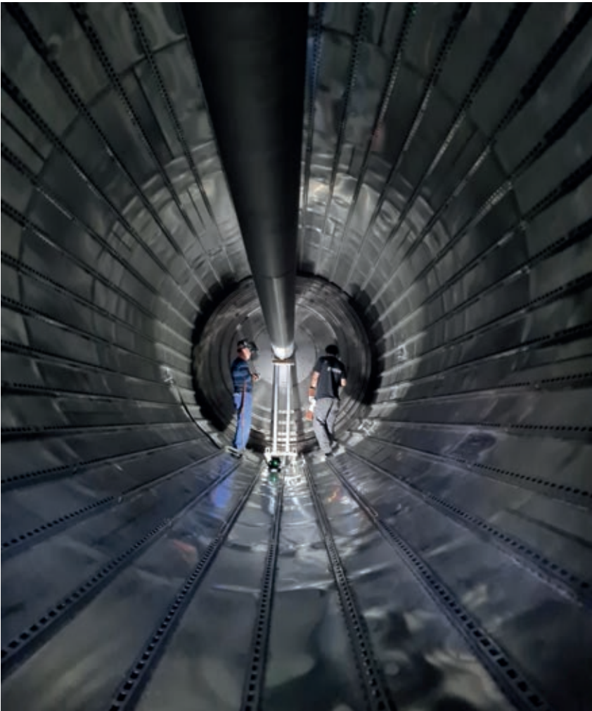
El interior del tanque de combustible. (Imagen: ArianeGroup)
