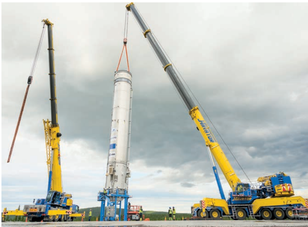
Instalación del modelo Themis T1H en la zona de lanzamiento. (Imagen: Swedish Space Corporation/ArianeGroup/Mattias Forsberg)
