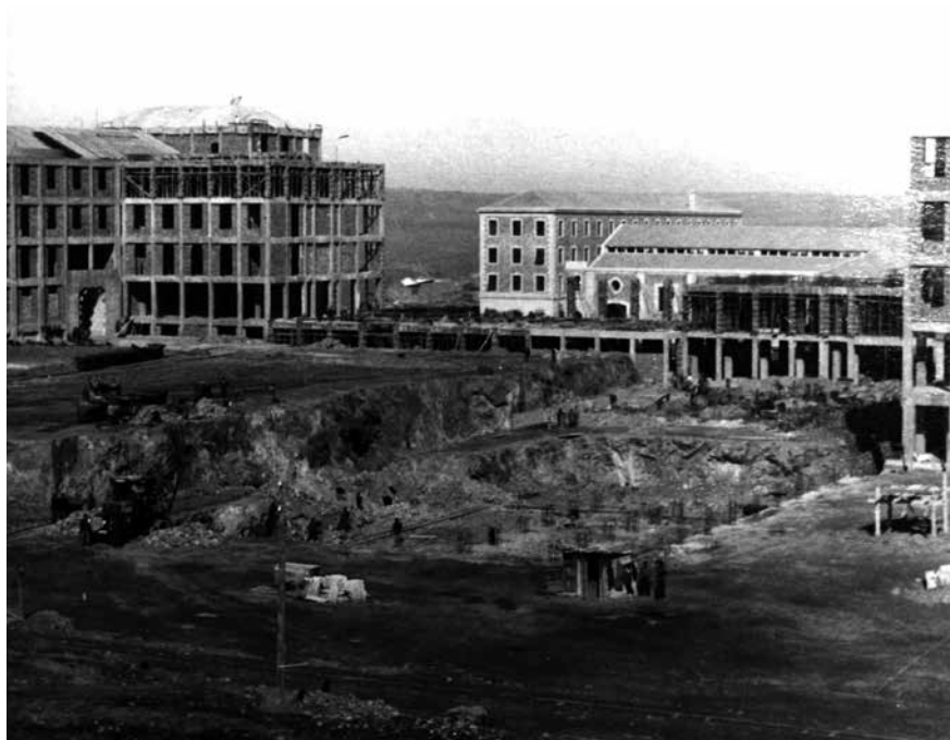
Academia de Infantería en construcción
